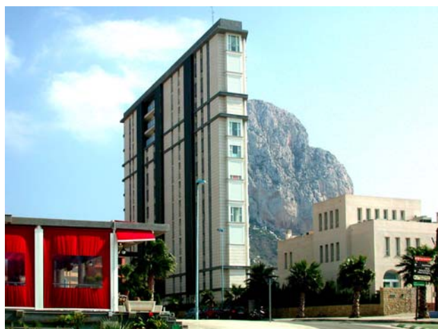
Calpe: „Wohnmaschine“ in Brief-Form (Der hintere Gebäudeteil ist aber viel breiter)
